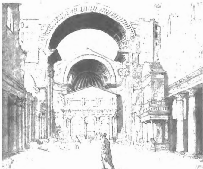
Fig. 1 - M. VAN HEEMSKERK, Veduta del "cantiere interrotto" della Basilica di San Pietro (1532 -1536). Oltre alle grezze membrature della nuova basilica e alla porzione sopravvissuta della fabbrica costantiniana al centro campeggia il "tegurio" progettato nel 1513 da Bramante come protezione della tomba di san Pietro e dell'altare papale.
